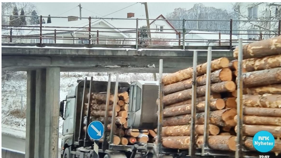
Ikke mye klaring i undergangen ved Hadeland Glassverk.
